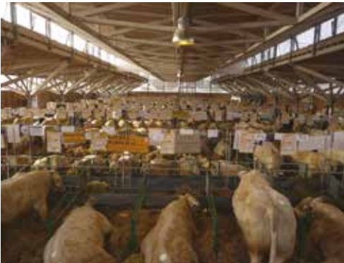
Foire agricole sous la halle contemporaine de Luzy. La faible rentabilité de la production de bovins maigres charolais pose la question de l'avenir du modèle agricole... @J. Guérin - AMD Architectes
